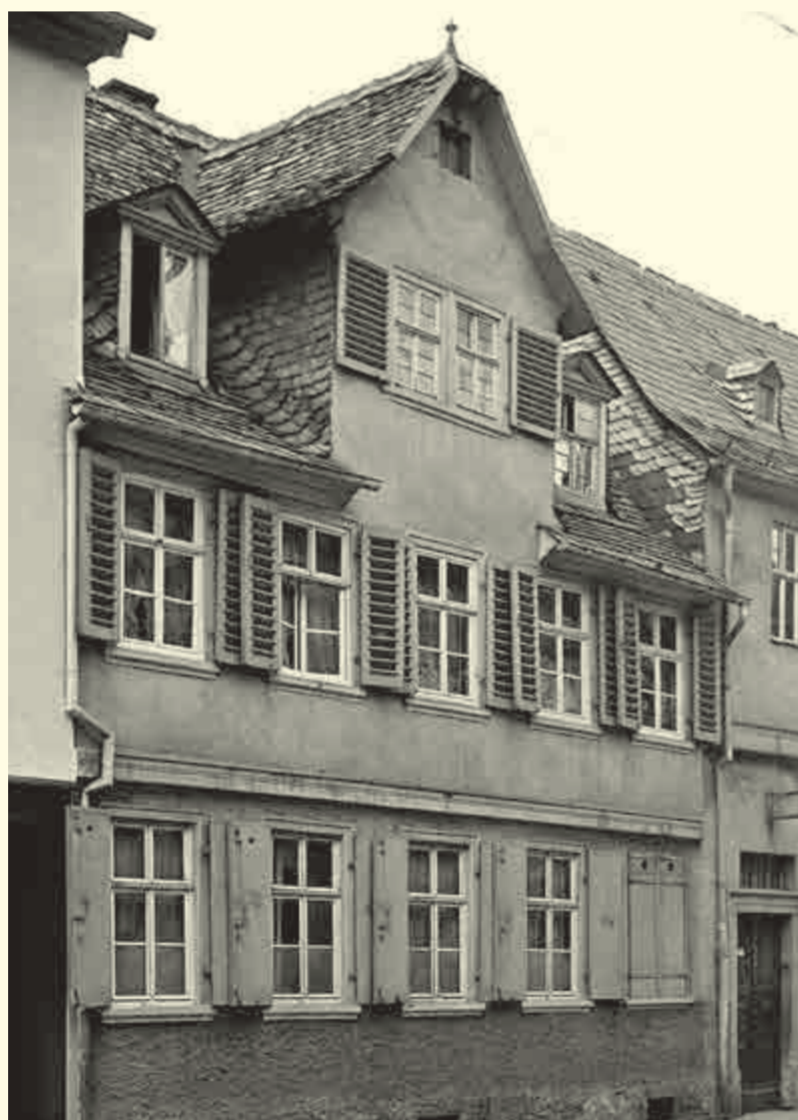
Haus Schlemmer 1939, Fabrstraße 11 (Medienzentrum Hanau)
